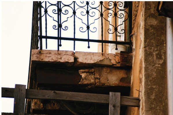
Lerepedt, megerősített sarkok, utólagos konzolok
