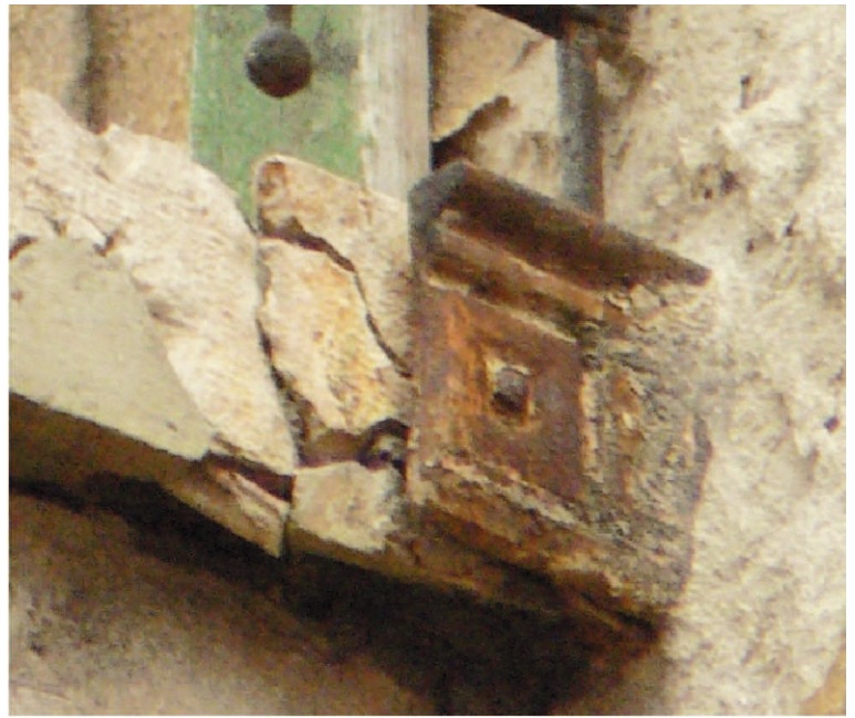
Öntöttvas szegély maradványai a keleti oldalerkélyen, a második emeleten
