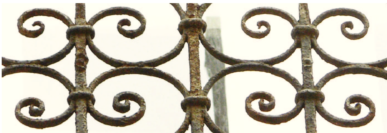
Kovácsoltvas rozetták maradvánai a függőleges pálcák közepén
