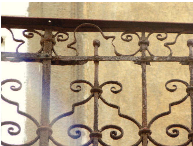
A vasak korrózió okozta károsodásai
