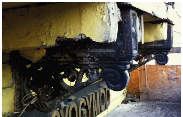
A keleti oldalerkély konzolja az első emeleten Közép erkély konzolja az első emeleten
