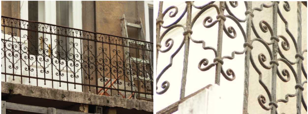
Előregyártott díszek méretre igszítása a sarkon
