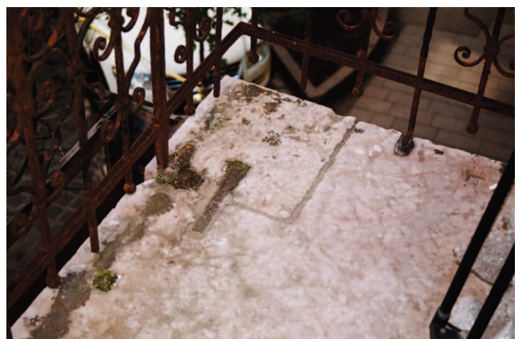
Az oszlopok jelenlegi bekötése és a régi csaplyukak
