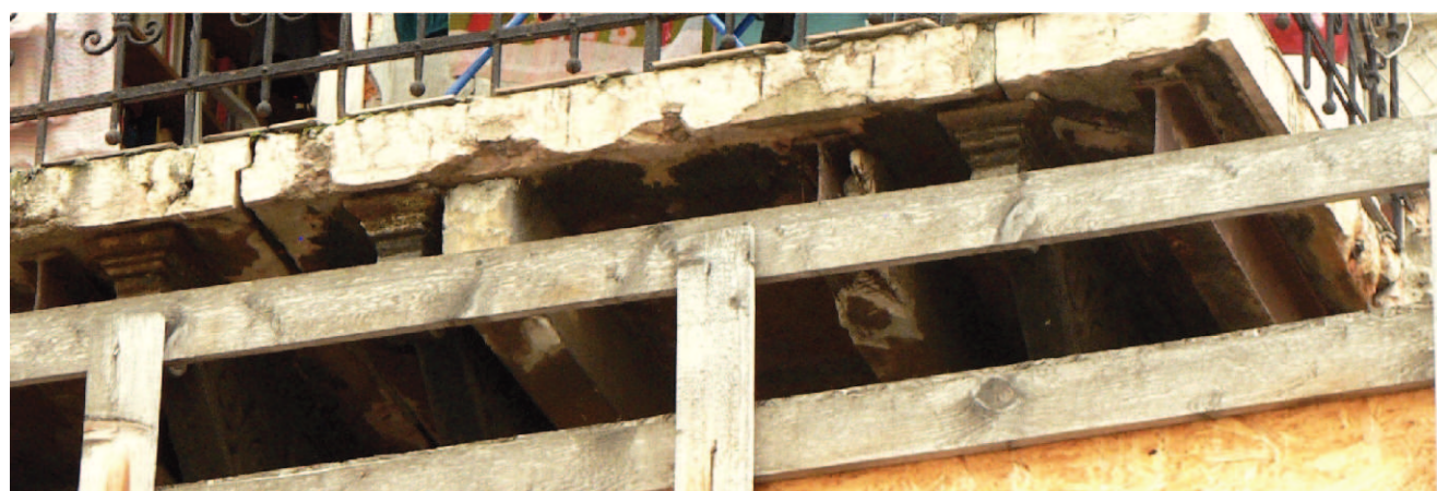
A második emeleti oldalerkélyek öntöttvas konzoljai
