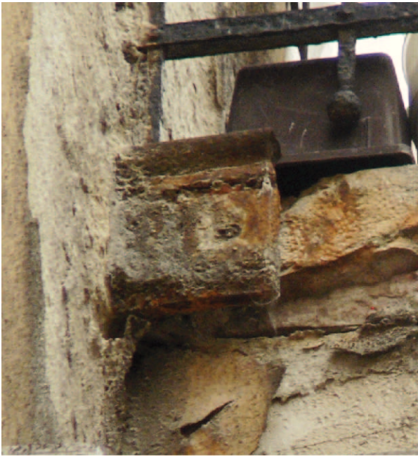
Öntöttvas szegély maradványai a keleti oldalerkélyen, a második emeleten
