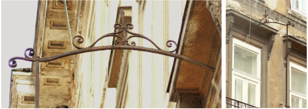
A korlát kilengését csökkentő kötő ív
